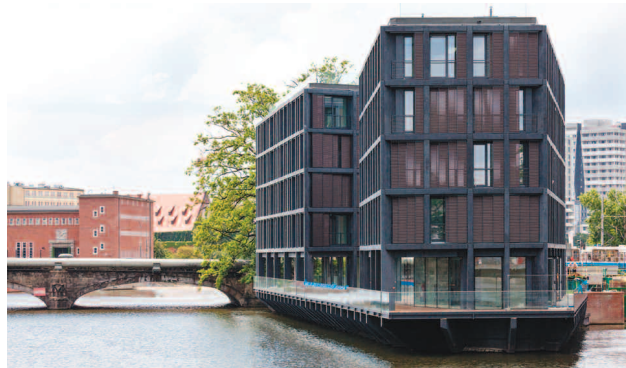
Fot. 3. Budynek mieszkalno-usługowy Marina III we Wrocławiu – barwione elementy prefabrykowane wykonane zostały przez firmę Betard
