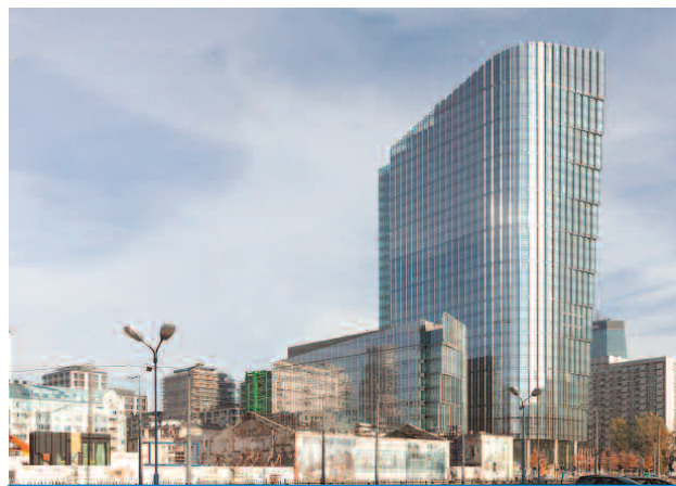
Mennica Legacy Tower – Warszawa, Polska. Projekt: Goettsch Partners/Epstein. SOPREMA dostarczyła system dachu tradycyjnego, bitumicznego, dwuwarstwowego B_{roof}(t1) , RE 15, RE 30
