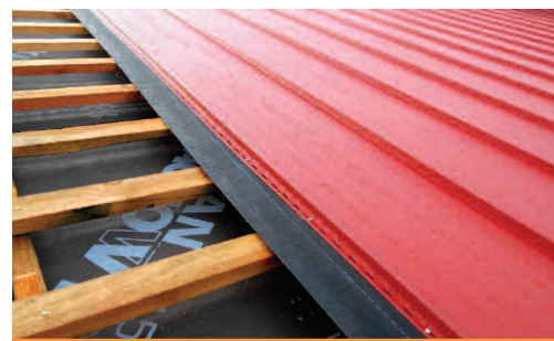
Dach pochyły pokryty blachą Fot. Marma Polskie Folie
