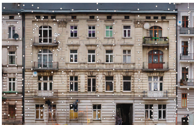
Fot. 1. Przykład poprawnego rozmieszczenia zdjęć równoległe do elewacji – efekt niemożliwy do osiągnięcia bez wykorzystania dronów
