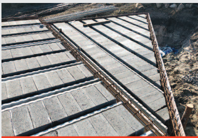
Fot. 4. Docinanie belek i pustaków
