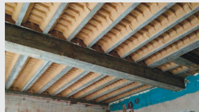
Fot. 6. Wymiana stropu
