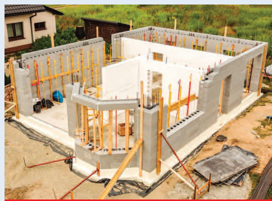
Budowa domu jednorodzinnego w technologii IZODOM2000
