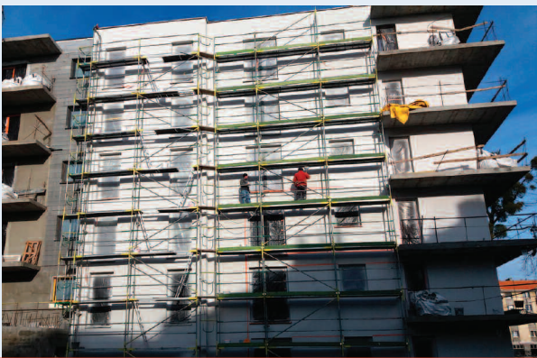
Wielokondygnacyjny blok w technologii IZODOM2000
