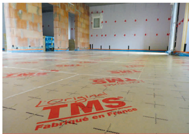
Przed ułożeniem płyt TMS®, na ścianie przykleja się taśmę dylatacyjną EFIRIVE® w celu wyeliminowania mostków termicznych
