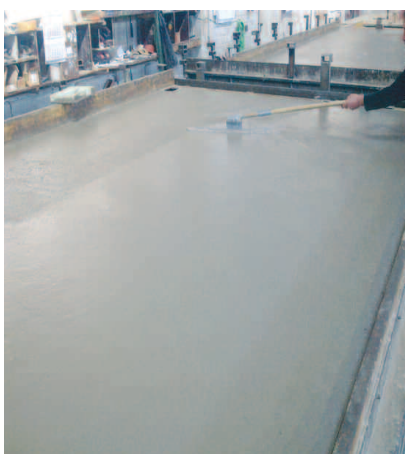
Fot. 2. Łatwa i szybka obróbka powierzchni mieszanki betonowej zawierającej domieszkę MasterEase [2]
