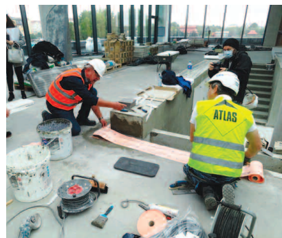
Fot. 5. Szkolenie dotyczące montażu taśm
