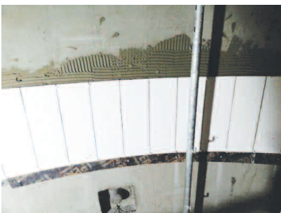
Fot. 4. Pierwszy rząd płytek w tubie (na głębokości 40 m) przymocowano na klej ATLAS Geoflex Express
