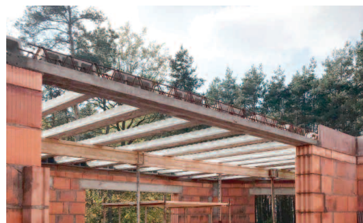
Fot. 5. Podciąg PPR firmy Rector
