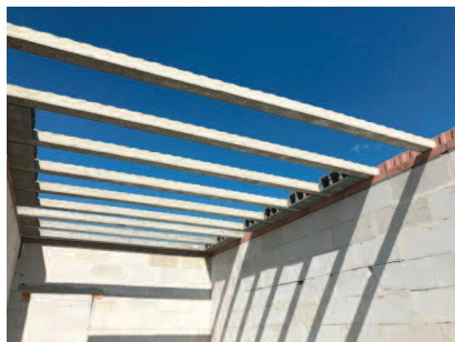
Fot. 1. Zamontowane belki sprężone firmy Rector
