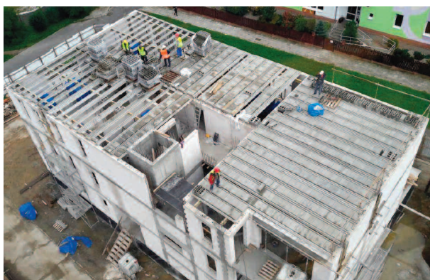
Fot. 2. Montaż stropu Rectobeton
