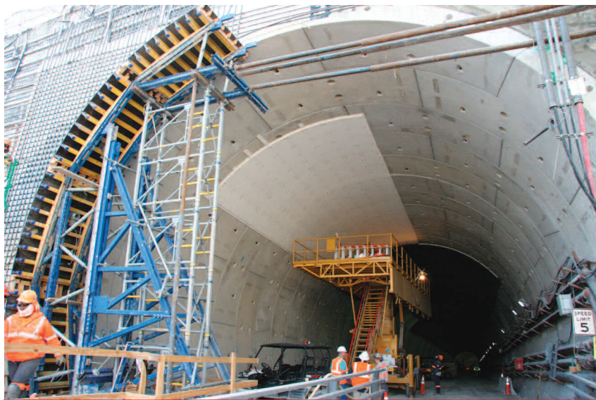
Zabezpieczenie konstrukcji tunelu płytami ogniochronnymi PROMATECT®
