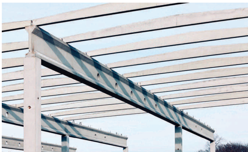
Fot. 1. Pokrycie dachowe o konstrukcji płatwiowej
