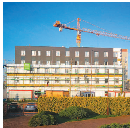
Elewacja z zamontowanymi barierami ogniowymi
