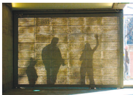
Fot. 5. Prefabrykowane elementy z betonu transparentnego wykonane z wykorzystaniem światłowodów w celu uzyskania efektu częściowej przezroczystości [8]
