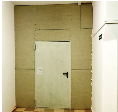
Fot. 1. Ściana z płyt gipsowo-kartonowych na profilach aluminiowych wykonana przez firmę Izodom w 6 h w szpitalu w Zgierzu zanim przyjął pierwszych pacjentów z chorobą zakaźną
