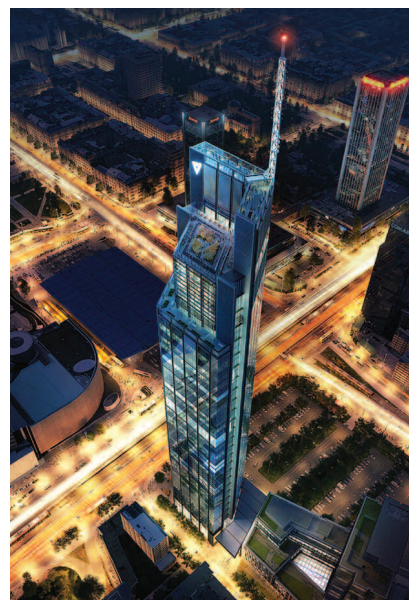
Fot. 3. Najwyższy budynek wznoszony w UE – Varso Tower, Warszawa (grafika ©HB Reavis)
