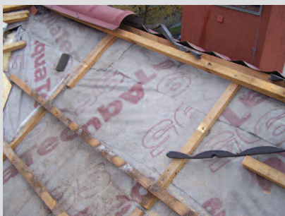
Fot. 2. Dach z fotografii 1 w trakcie remontu. Przedostatnia łąta została zdjęta i widać ją na fotografii 3. Wymieniono jeszcze 3 łąty. Razem 4 oprócz ostatniej, czyli tej podtrzymującej gąsior, która na całym remontowanym fragmencie dachu była w dobrym stanie
