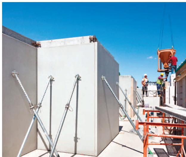
Fot. 6. Zamontowane kosze zbrojeniowe oraz betonowanie (drugi plan)
