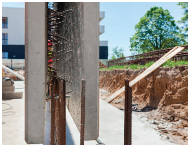
Fot. 1. Widok z boku ściany zespolonej typu filigran
