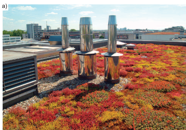
Dach zielony: a) ekstensywny; b) intensywny
