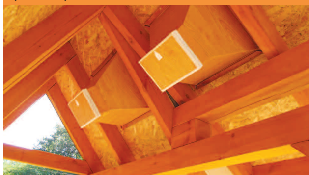
Fot. 5. Dach dedykowany badaniom UV wybudowany w 2019 r.
