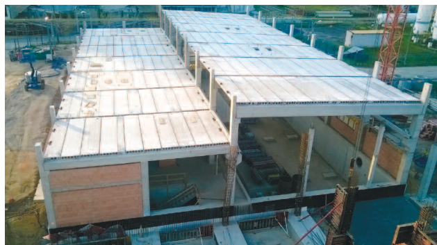
Fot. 2. Płyty HC na budynku produkcyjnym w Opolu
