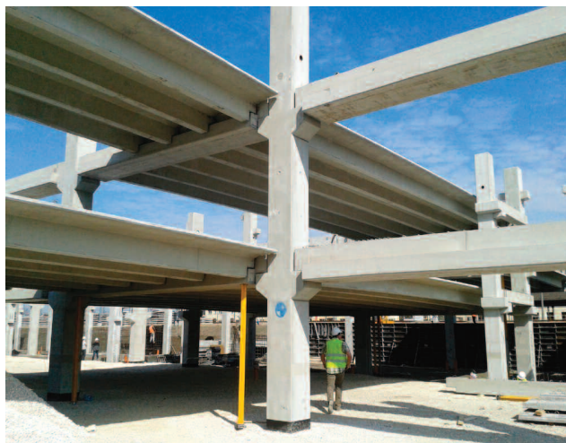
Fot. 3. Strop z płyt TT w trakcie montażu
