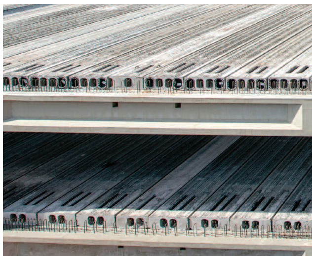
Fot. 1. Stropy z płyt HC w trakcie montażu
