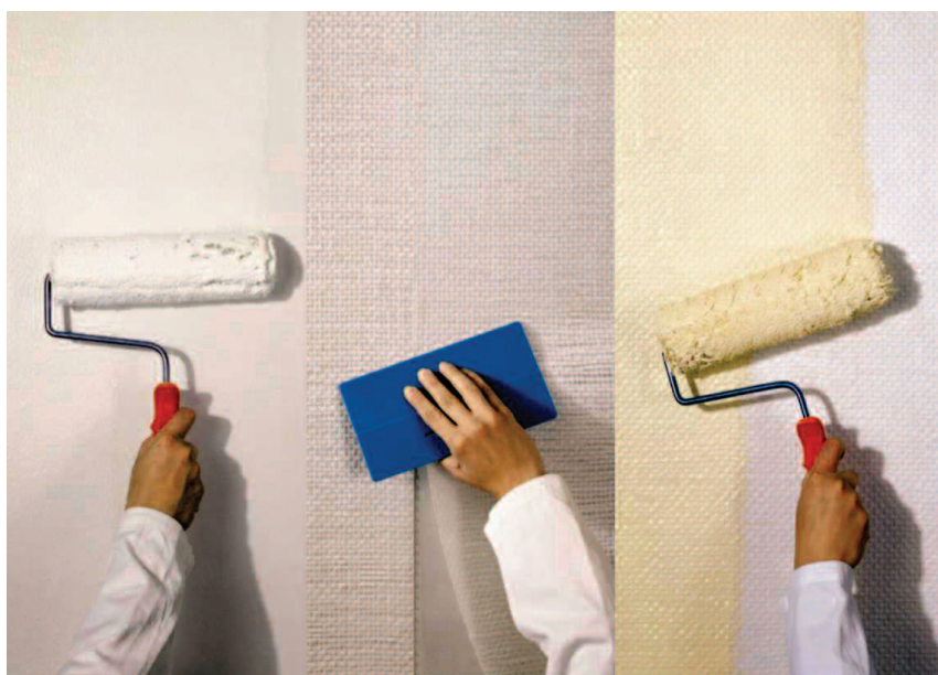
Sposób nakładania warstw systemu PUR
