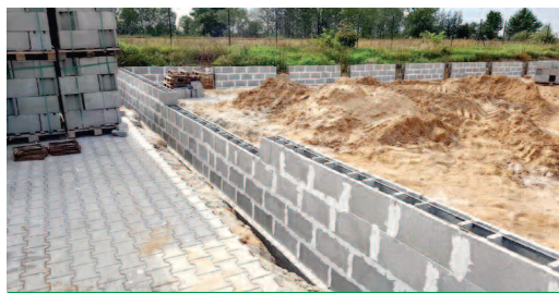
Fot. 1. Sposób łączenia elementów podstawowych PS24 w murze
