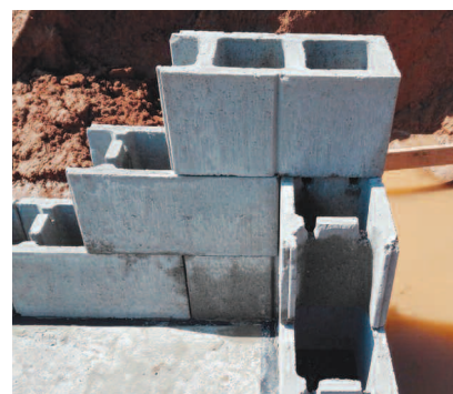
Fot. 4. Układanie elementu narożnego PS24 na zbrojeniu poziomym
