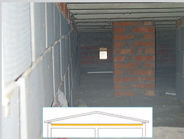
Fot. 1. Przestrzeń wentylacyjna dachu budynku wielorodzinnego, z wełną na stropie betonowym, z poszyciem wykonanym z płyt korkowych ułożonych na ażurowych ścianach
