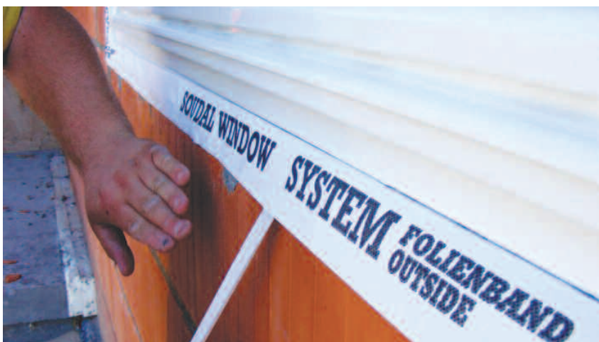
Taśma paroprzepuszczalna SWS chroni piankę przed wodą opadową i umożliwia migrację pary wodnej na zewnątrz budynku
