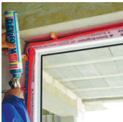
Dzięki piance Flexifoam montaż okien można wykonać w temperaturze do -10^{\circ}\text{C}
