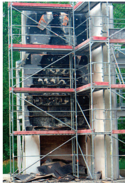
Fot. 2. Widok ściany badawczej po usunięciu okładziny
