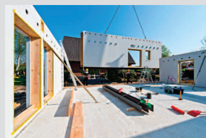
Montaż przegród fermacell® na budowie
