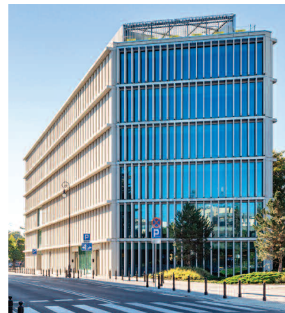
Fot. 3. Budynek Komisji Sejmowych
