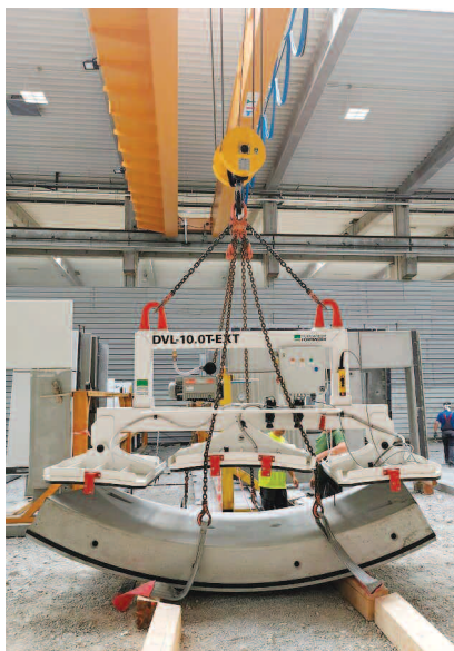
Fot. 2. Prefabrykowany element żelbetowy obudowy tunelu
