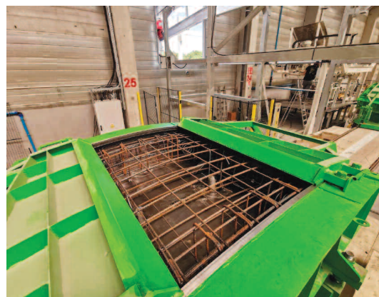
Fot. 3. Montaż zbrojenia w formie stalowej
