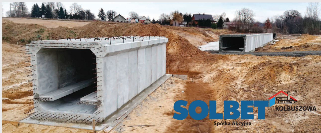
Montaż przepustów skrzynkowych na budowie drogi ekspresowej S19
