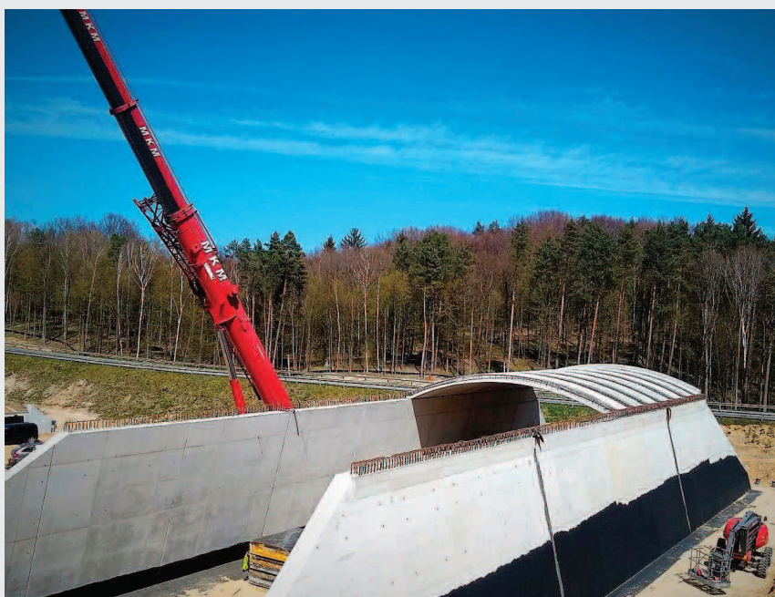
Montaż prefabrykowanych elementów mostowych optemARCH w ciągu drogi ekspresowej
