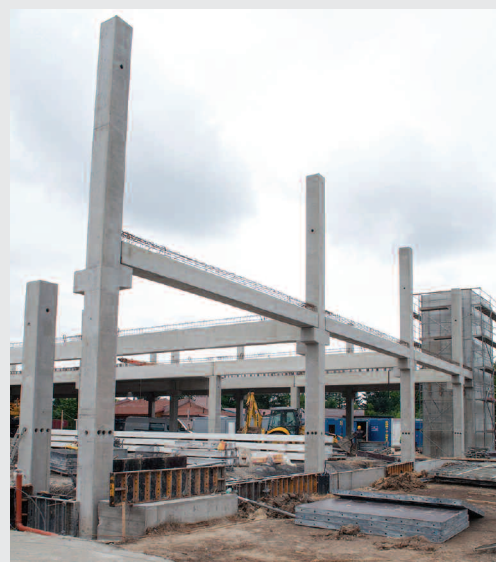
Montaż hali z elementów wyprodukowanych w Zakładzie Betonów w Kolbuszowej
