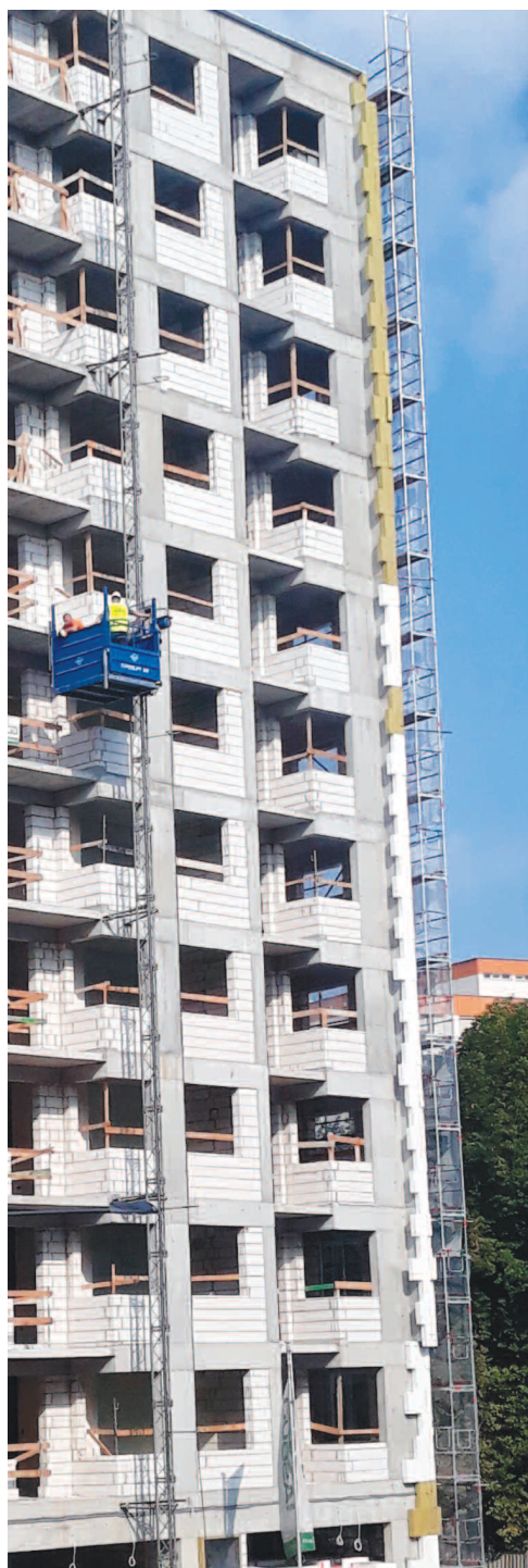
Przykład zastosowania barier ogniowych w systemie ETICS
