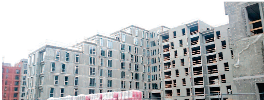
Fot. 1. Budynek mieszkalny w Kopenhadze
