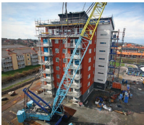
Fot. 3. Budynek mieszkalny w Szwecji wzniesiony w technologii prefabrykowanej
