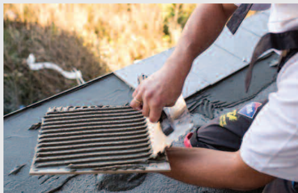
Fot. 3. Nałożenie zaprawy na płytkę
