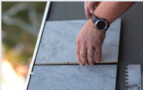
Fot. 4. Przyklejenie płytki do warstwy hydroizolacyjnej metodą „mokre na mokre”
