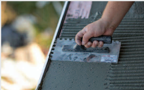
Fot. 2. Wygładzenie zaprawy w celu uzyskania ciągłości warstwy hydroizolacyjnej
