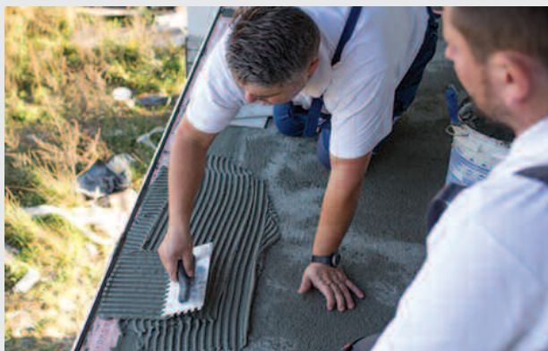
Fot. 1. Przyklejenie profili i taśm, wykonanie warstwy izolacyjnej pacą zębatą 10
