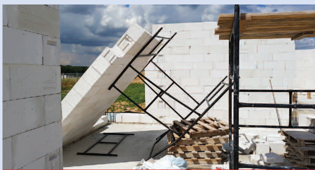
Ściana przewrócona przez trąbę powietrzną wciąż jest monolitem, co świadczy, że zaprawa została właściwie dobrana. Do murowania zastosowano zaprawę do cienkich spoin SOLBET 0.1
