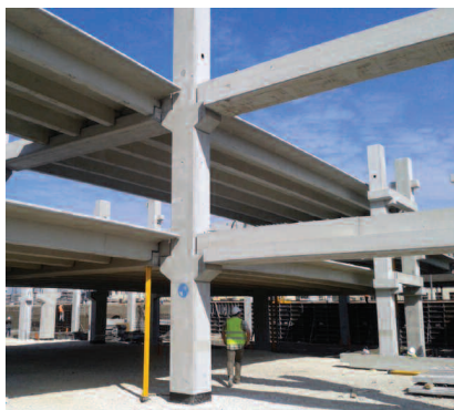
Fot. 5. Płyty TT układane na belkach stropowych – realizacja parkingu wielopoziomowego w Tarnobrzegu
