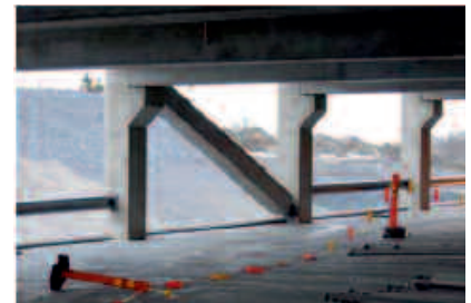
Fot. 2. Stężenia żelbetonowe
