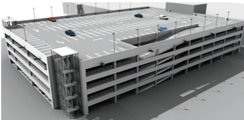
Fot. 1. Parking wielopoziomowy z prefabrykatów żelbetonowych
