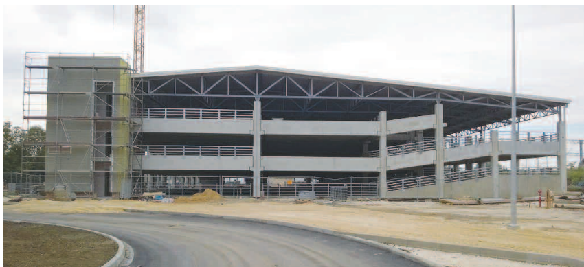
Fot. 4. Parking wielopoziomowy z żelbetowych elementów prefabrykowanych wzniesiony w Tarnobrzegu
