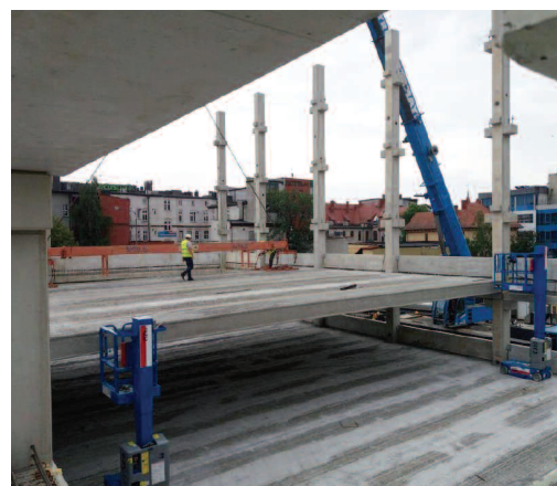
Fot. 7. Płyty HC układane na belkach
