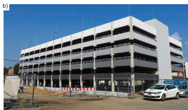
Fot. 6. Parking w Rybniku z żelbetowych elementów prefabrykowanych: a) model 3D; b) zrealizowany obiekt
