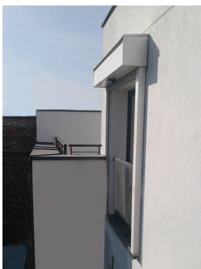
Przeciwpożarowa elastyczna kurtyna okienna Marc-Ok wkomponowana w design budynku
