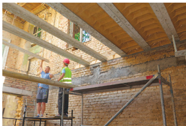
Fot. 5. Montaż stropów RECTOR
