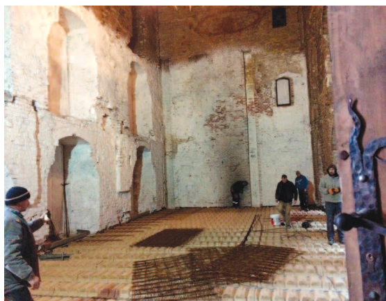
Fot. 3. Układanie stropu RECTOLIGHT na zamku w Gniewie
