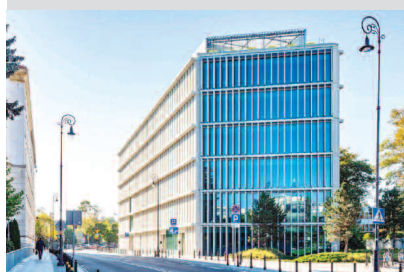
Nagroda główna – budynek Komisji Sejmowych w Warszawie
