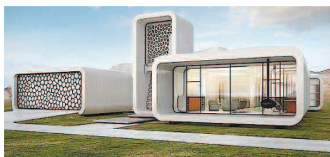
Fot. 7. Druk przestrzenny zastosowany do budowy domu z prefabrykatów
