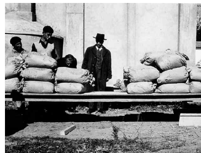
Fot. 3. Badanie prefabrykowanych belek sprężonych
