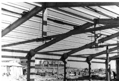
Fot. 5. Prefabrykowane kratownice dachowe
