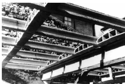
Fot. 4. Belki sprężone, którym towarzyszą nowe, w tamtych czasach, bloki betonowe
