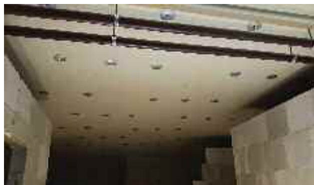
Sufit w garażu podziemnym, w którym jako izolację zastosowano płyty ISOVER Stropmax 31
