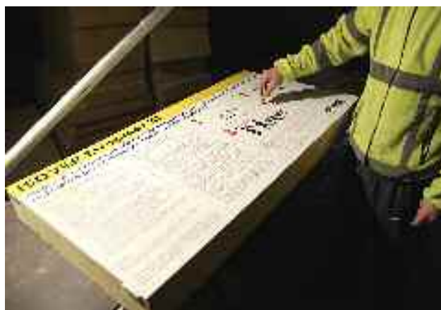
Szablon ułatwiający wyznaczanie punktów odwiertu do mocowania izolacji
