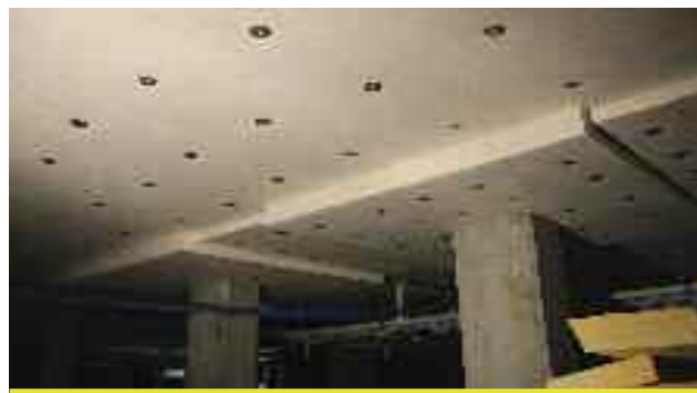
Sufit pełen uskoków – boki izolacji ISOVER Stropmax 31 zawinięte są welonem szklanym bez konieczności podklejania jego fragmentów
