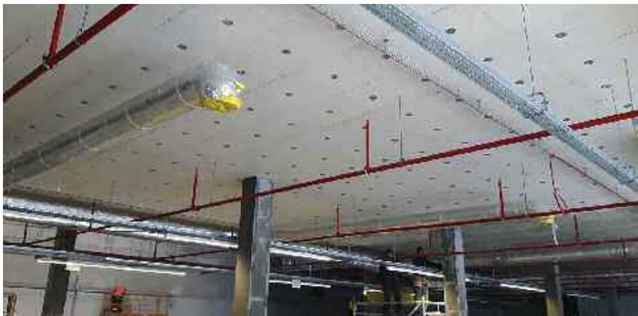
Zastosowanie izolacji ISOVER Stropmax 31 w hali produkcyjnej w celu zmniejszenia poziomu hałasu od urządzeń
