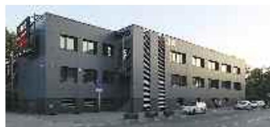
Budynek siedziby Zabrzeńskiego Przedsiębiorstwa Energetyki Ciepłej w Zabrzu nagrodzony tytułem „Modernizacja Roku 2017” oraz nagrodą miesięcznika „Materiały Budowlane”
