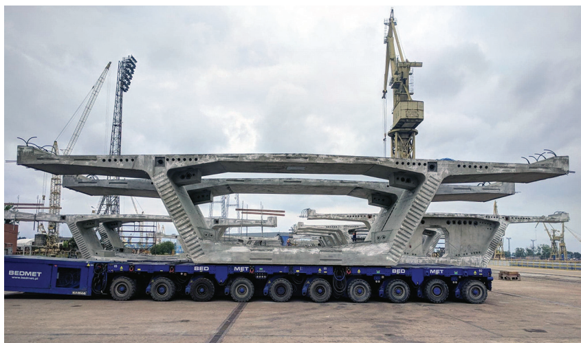
Fot. 1. Segmenty mostu na ostatnim etapie produkcyjnym, przed wysyłką na budowę do Danii
