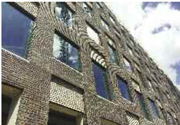
Zamontowane elementy trójwarstwowe. Warstwa elewacyjna to przecięte połówki cegły klinkierowej
