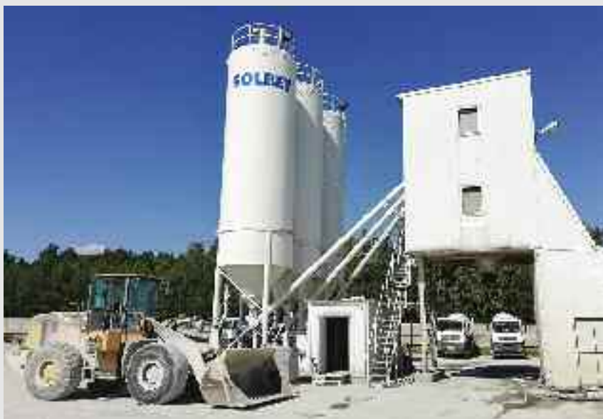
Zakład Betonów w Lipiu k. Rzeszowa
