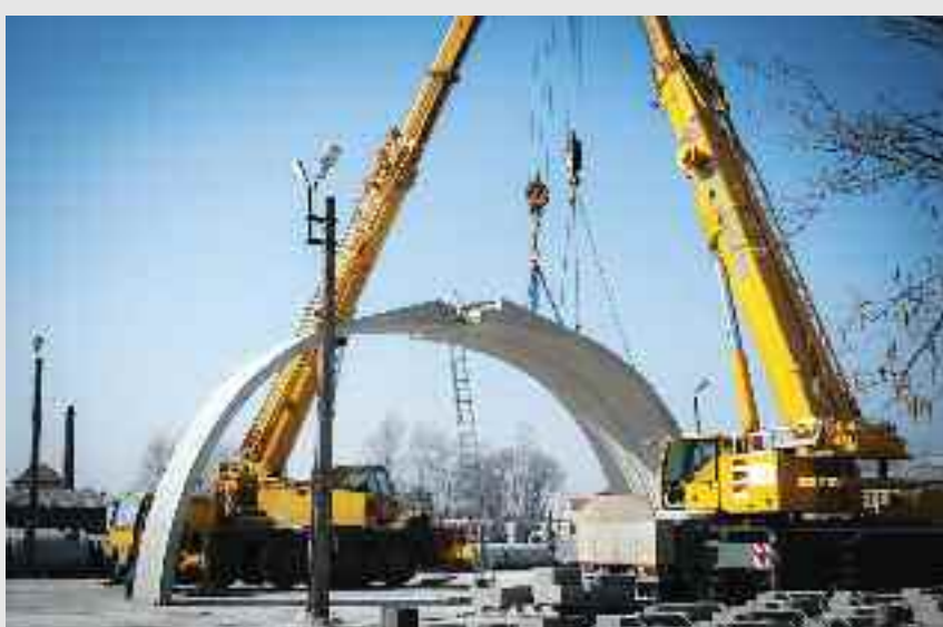
Montaż elementów łukowych typu Techspan, wyprodukowanych na podstawie dokumentacji firmy Freyssinet
