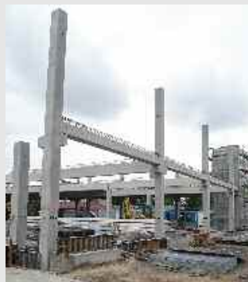
Montaż hali z elementów wyprodukowanych w Zakładzie Betonów w Kolbuszowej
