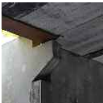
Oparcie płyt kanałowych na placu budowy
