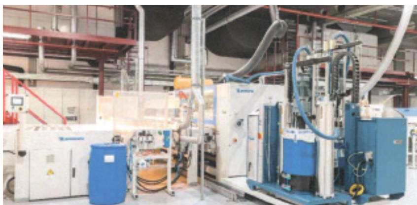
Nowa linia lakiernicza w Leutkirch
