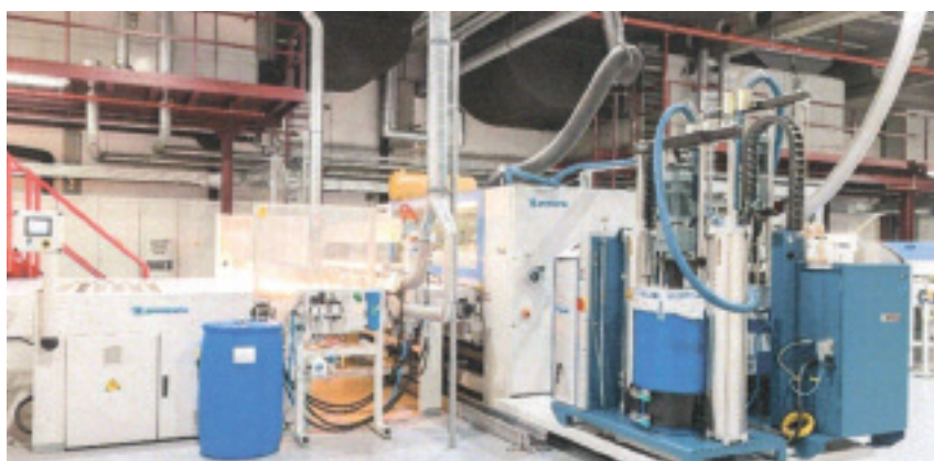
Nowa linia lakiernicza w Leutkirch
