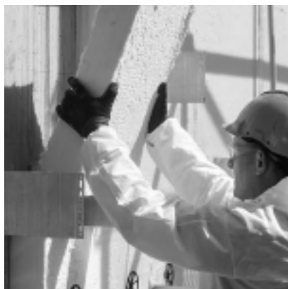
Montaż izolacyjnych płyt nowej generacji – Slentex®
